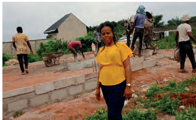
Bau des neuen Schulhauses
